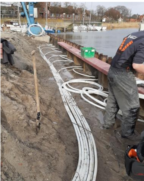
Damwanden met leidingenwerk
